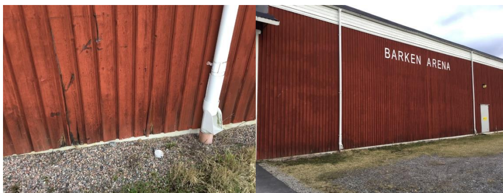
Delar av fasadytan.
