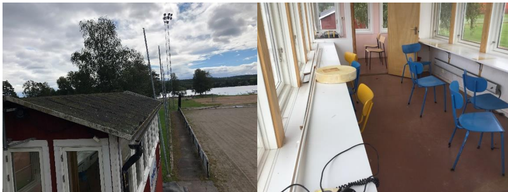
Taktäckning samt del av invändiga ytskikt.
