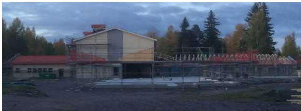
Nytt demensboende under byggnation, beräknas vara klart 2018
