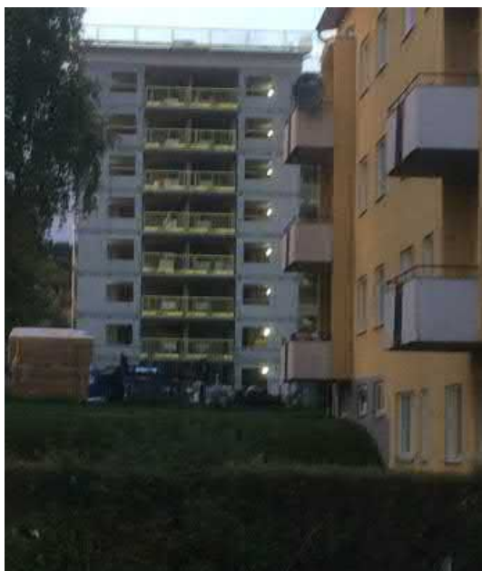
Nytt flerbostadshus under byggnation 2017
